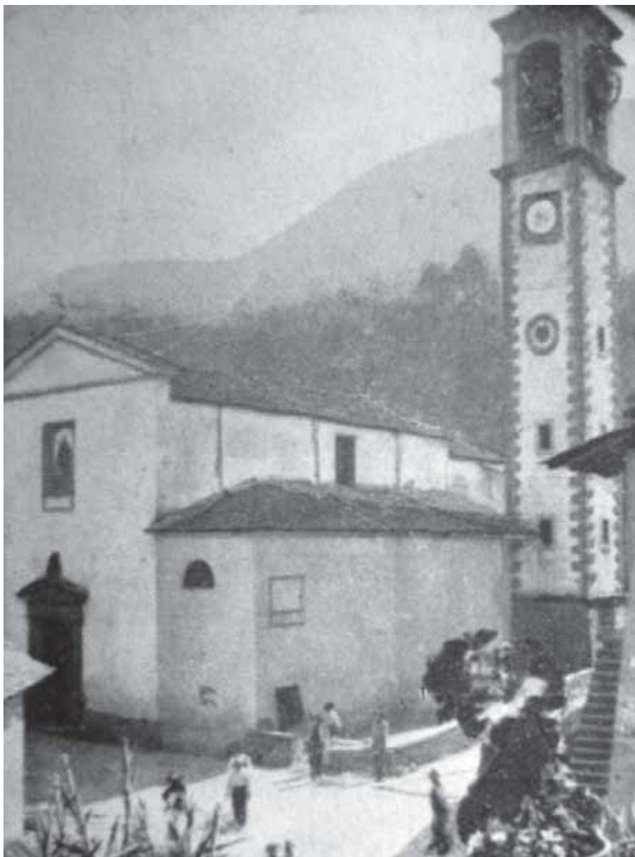
Niardo, antica parrocchiale (da B. BARBIERI - G. RINCHETTI, Niardo Valle Camonica , Niardo 1976). Si tratta dell'antica parrocchiale demolita nel 1907 per costruire sulla stessa area la chiesa attuale. Da decenni la chiesa aveva ormai manifestato la sua inadeguatezza dimensionale, tanto che il corpo di fabbrica alla destra dell'ingresso era un ampliamento del 1861, realizzato come ex-voto dai parrocchiani per la remissione della polmonera (pleuropolmonite contagiosa) che aveva colpito il bestiame.
