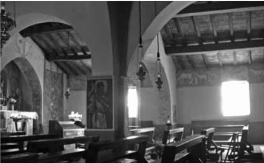
Fig. 12 - Sul pilastro centrale poggiano gli archi della fase edilizia rinascimentale.
