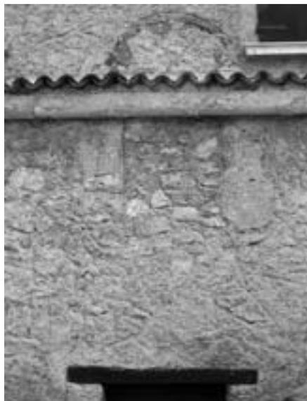
Fig. 17 - Finestrella con spallette in pietra e centinatura in laterizio.
