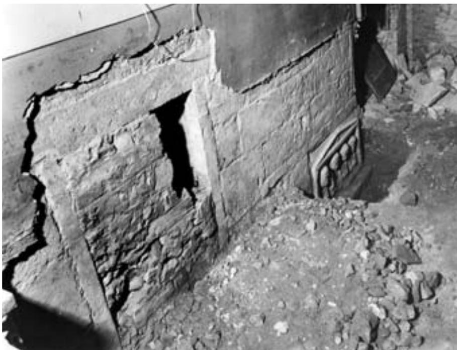
Fig. 3 - Muratura settentrionale della cripta (XII secolo) con reimpieghi d'epoca romana.
