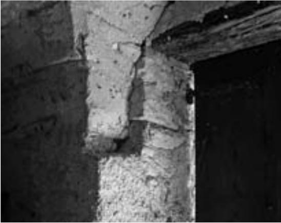
Fig. 19 - Particolare del punto di imposta della volta.
