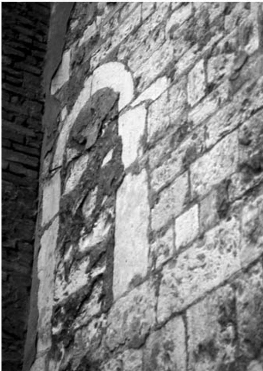
Fig. 16 - Muratura e monofora del cleristorio del presbiterio di XII secolo.
