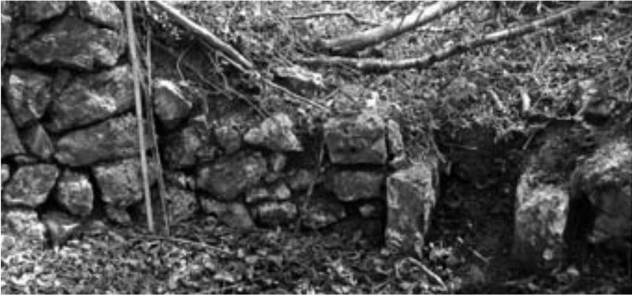
Fig. 3 - Muratura circolare e apertura di accensione della calchera in loc. Prati Secchi.
