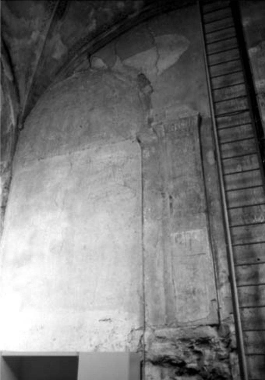
Fig. 14 - Pilastro ed arco della parete divisoria meridionale del presbitero di XII secolo;
