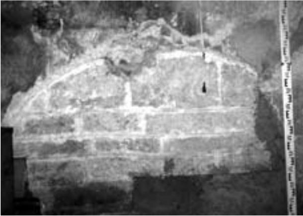
Fig. 5 - Navata nord della cripta: paramento e tracce delle volte romaniche.
