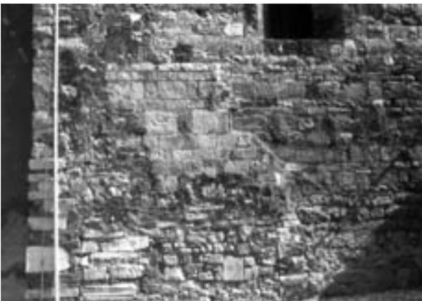
Fig. 7 - Lato sud del campanile duecentesco: il paramento a conci più regolari è una sopravvivenza del fianco meridionale della cripta di XII secolo.
