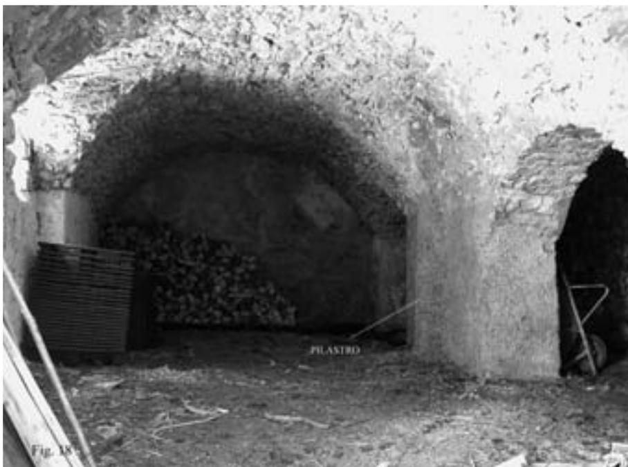
Fig. 18 - Solaio a volta del piano terra dell'ala.
