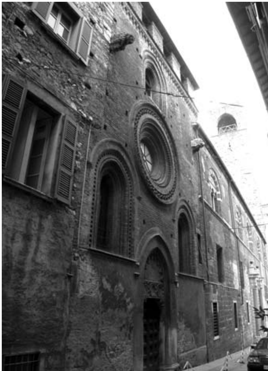
Affaccio della chiesa su vicolo S. Agostino.
