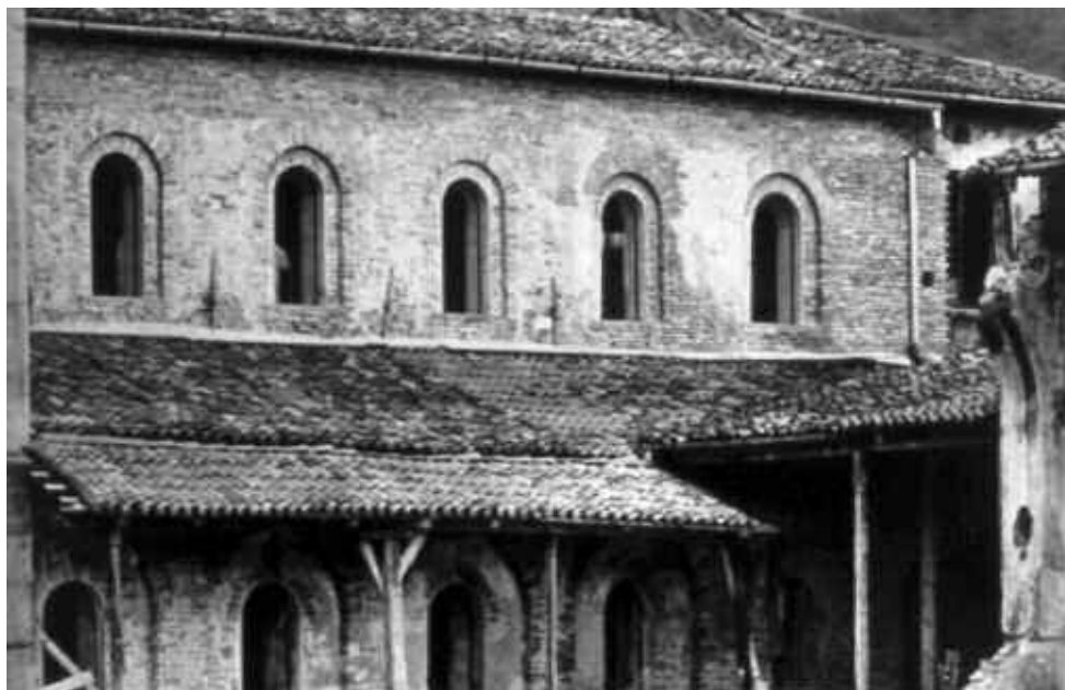
Esterno di San Salvatore prima restauri (lato meridionale).
